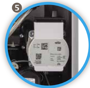
Pompa ad alta efficienza a modulazione totale
